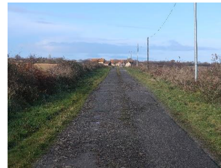
Route communale au droit du site Source : ARTIFEX 12/2021
