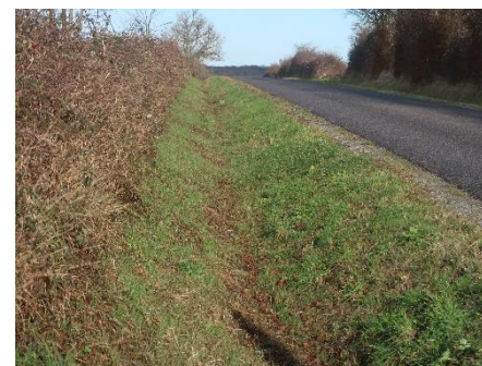
Fossé en limite Est du site d'étude Source : ARTIFEX 12/2021
