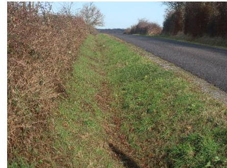
Fossé en limite Est du site d'étude Source : ARTIFEX 12/2021
