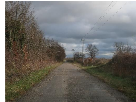
Route départementale D32A Source : ARTIFEX 12/2021
