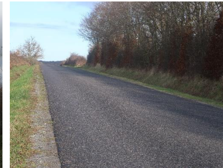
Route départementale D15 Source : ARTIFEX 12/2021
