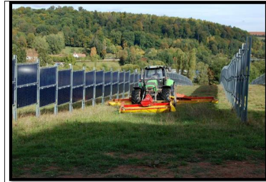
Panneaux verticaux Orientation Est/Ouest Espacement 8 m Favorise la fauche notamment sur des terres destinées à la luzerne
